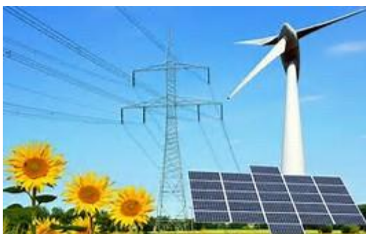
Zonnepanelen grootverbruikersaansluiting: SDE+
